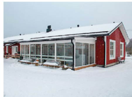
LC Korsnäs står bakom den inglasade altanen vid den nya matsals- och servicebyggnaden i anslutning till äldreboendet Buketten i Korsnäs.
