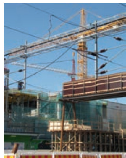
Rakennustyömaa saattaa näyttää sekavalta, mutta jossakin on jokin suunnitelma uuden aikaansaamiseksi. Tikkurilan asemakeskus valmistuu vuosina 2014–2019. Kuva: Thorleif Johansson.
