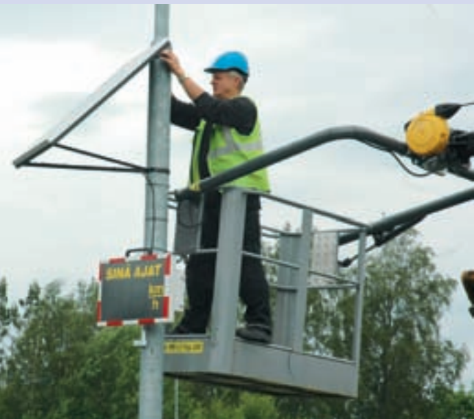
Aurinkopaneelia asentamassa sähköasentaja Mauri Tamminen. Kuva: Kurt Ratia.
