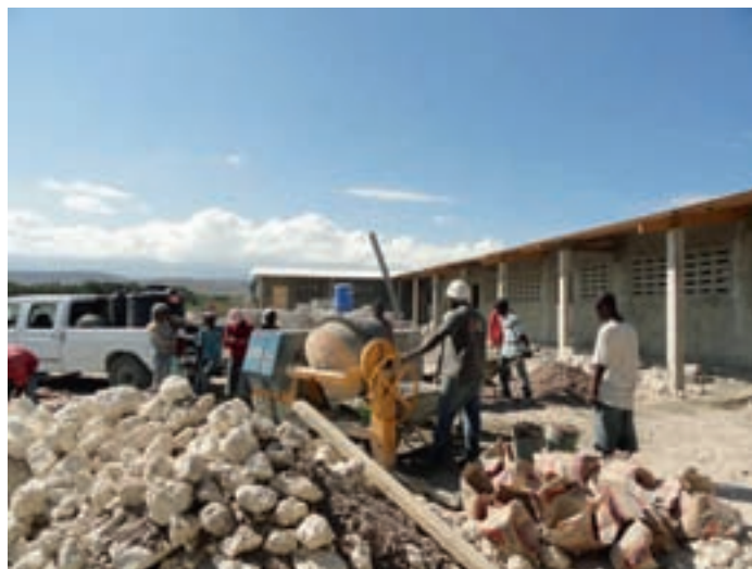
Timonnetan kylän koulun rakentamista. Koulu valmistuu huhtikuussa 2012.
