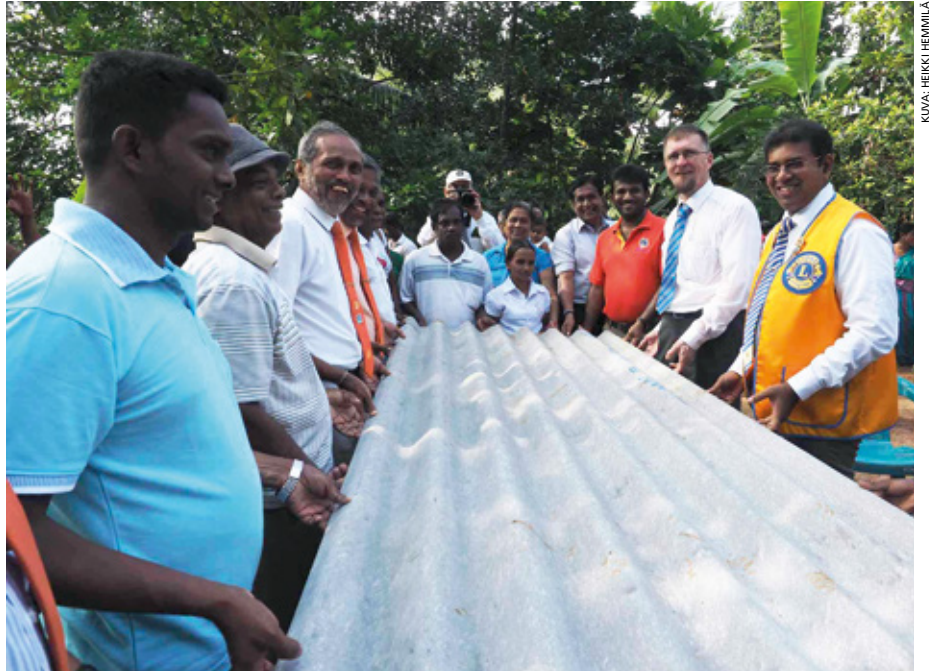
Osallistuimme toukokuisten rankkasateiden ja tulvien vaurioittamaan talojen korjaamiseen Ingiriyassa.
