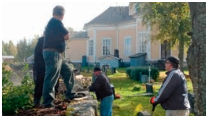
En del av bröderna samlades för att rensa gravgårdsmuren vid kyrkan.
