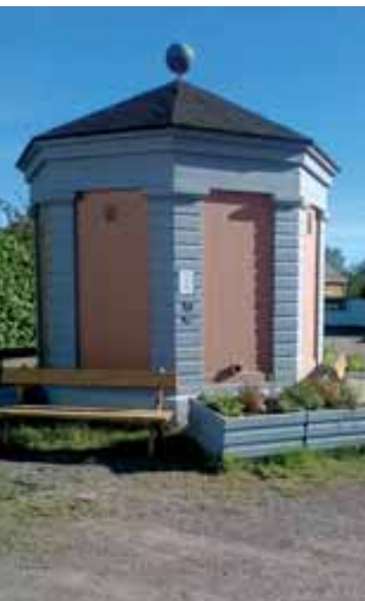
Suolatorin kaivo/pumpputalon restaurointi on myös LC Lovisa/Loviisan perintöprojekti.
