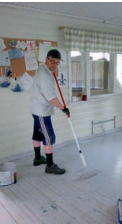
Huolellisten valmistelujen jälkeen lattian maalaaminen oli joutuisa työ. Kuva: Jouni Korhonen.
