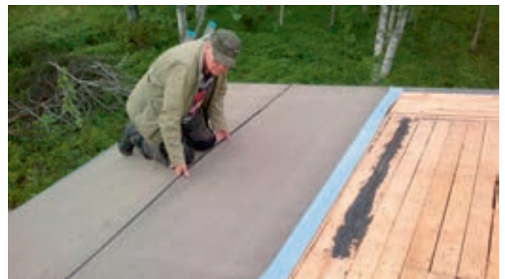
Majan katon laudoitus kunnostettiin sekä pohja- ja pintahuopa uusittiin. Samassa yhteydessä korjattiin piippu ja lopuksi pellitettiin. Kuva: Tauno Korpela.
