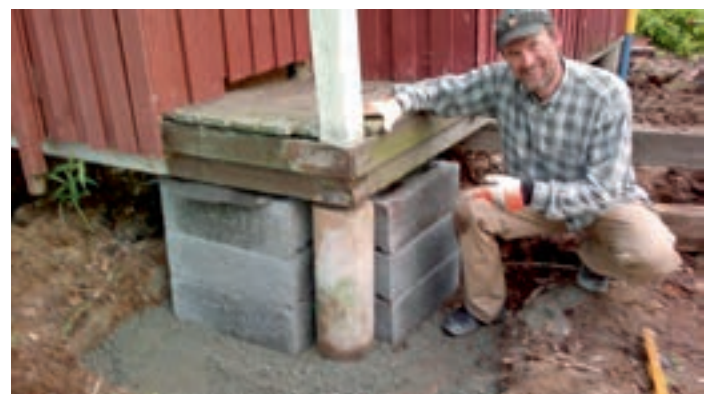
Tohtori Kettusen hyväksymä piharakennuksen perustus. Kuva: Tauno Korpela.
