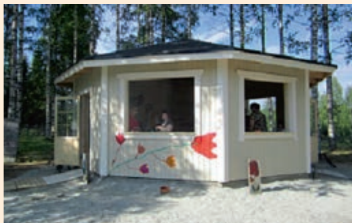
Kesäkeittiö/grillikatoksen valmistuttua rakennustyön lopputulokseen kaikki ovat erittäin tyytyväisiä. Kuva: Raimo Lääperi.
