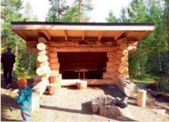
Euran leijonien rakentama laavu otettiin virallisesti käyttöön 9.9.2012 ja sen rakentamiseen kului lähes 300 työtuntia.
