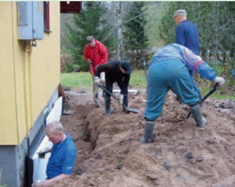
Sokkelin vesieristystyöt loppusuoralla. Kuva: Mauri Lindholm.
